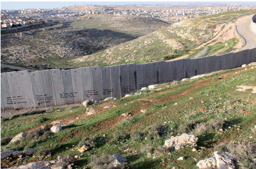
(74) Die Palästinenser nennen die Sperranlage mit den zahlreichen Checkpoints „Apartheidmauer“, da sie ihre Lebensbedingungen drastisch verschlechtert hat. Hier die Sperranlage bei Ramallah.
